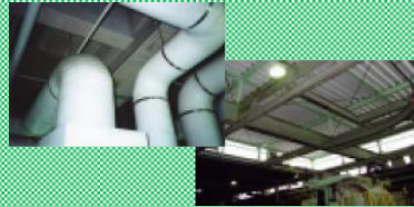
耐火被覆板(ケイカル板2種) 断熱材(煙突、屋根折板)、保温材
