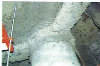
柱や梁に施工 吹付け石綿
